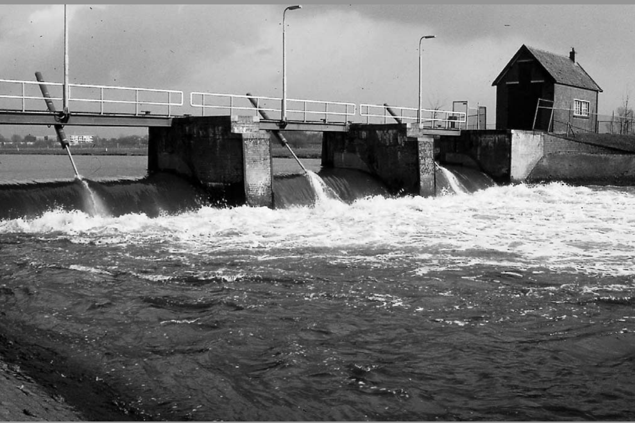
Weir (W1) at Vechterweerd / Stuw bij Vechterweerd
