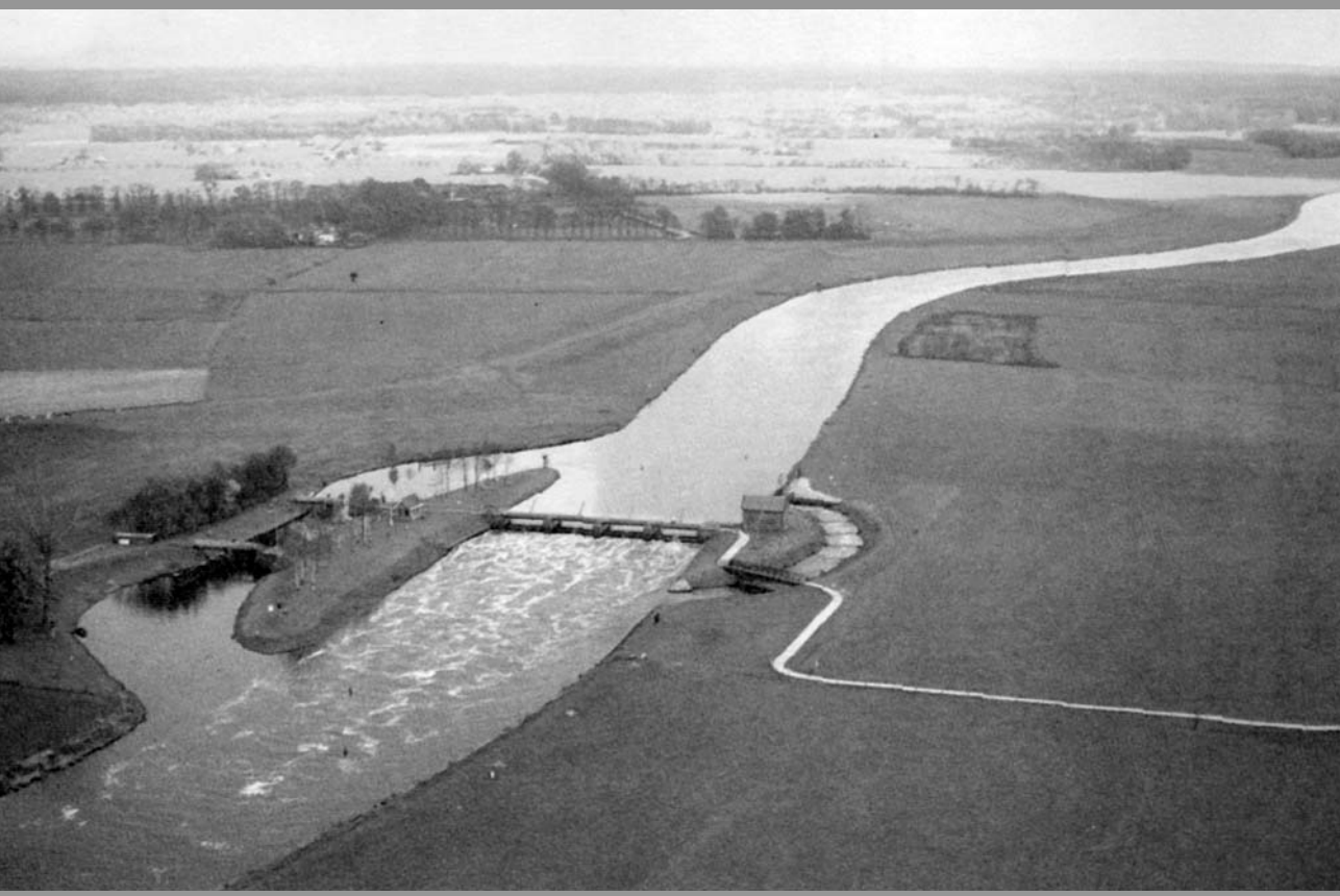
Ship lock, weir and fishway at Vechterweerd / Sluis, stuw en fistrap bij Vechterweerd
