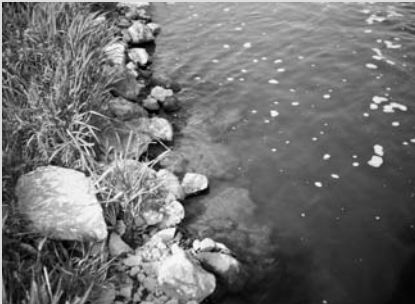
Riprap shore / Steenstortoever
