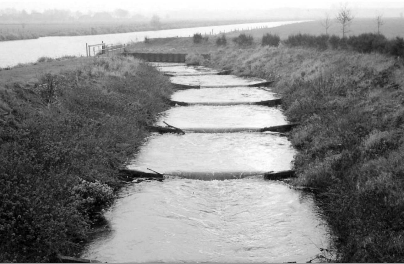
V-stepped fishway (F3) / Bekkenvistrap met V-vormige overlaten (Junne)
